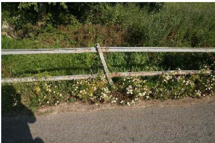
Deformace zábradlí
