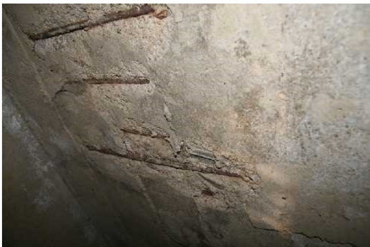
Odpadává krycí vrstva nosné výztuže NK.
