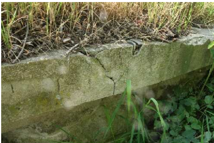
Trhliny na římsách. Krajnice porostlá vegetací.
