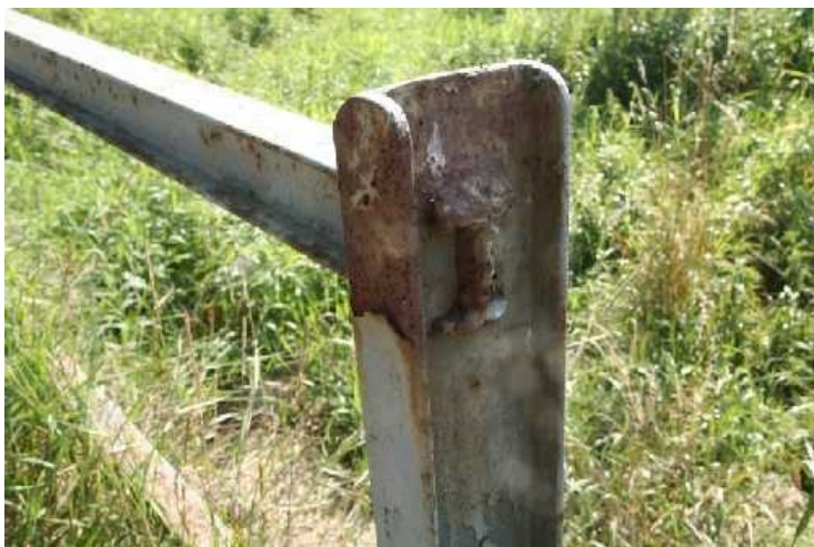
Koroze zábradlí.
