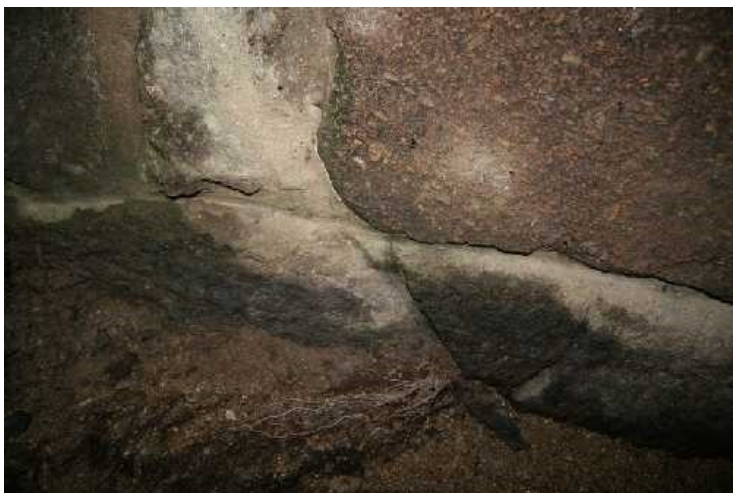
Trhliny ve spárování spodní stavby.
