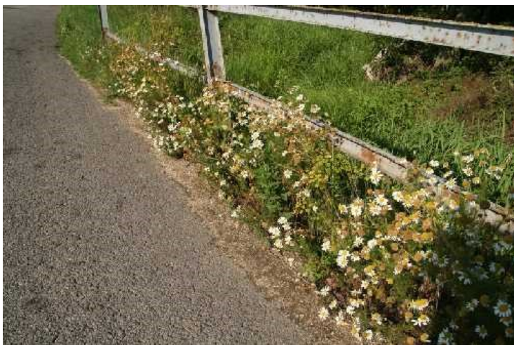
Vegetace na krajnici, zkorodované zábradlí.
