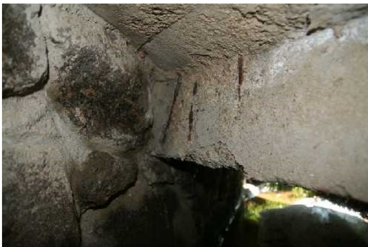
Odpadává krycí vrstva smykové výztuže, četné výluhy na líci NK a opěrách.
